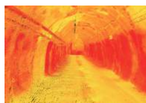
Облака точек тоннелей угольных шахт
