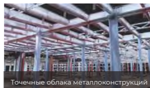
Точечные облака металлоконструкций
